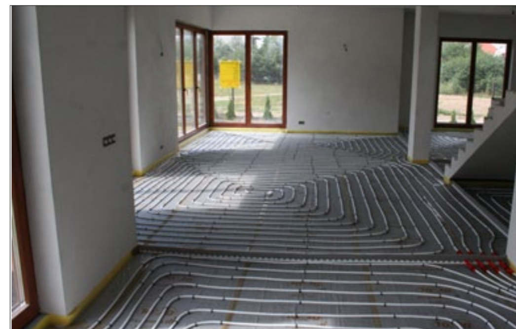
Wykonanie instalacji c.o. i ogrzewania podłogowego w domu jednorodzinnym
