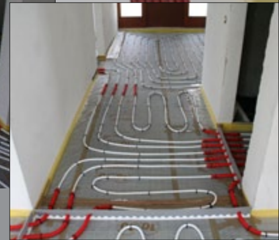
Wykonanie instalacji c.o. i ogrzewania podłogowego w domu jednorodzinnym
