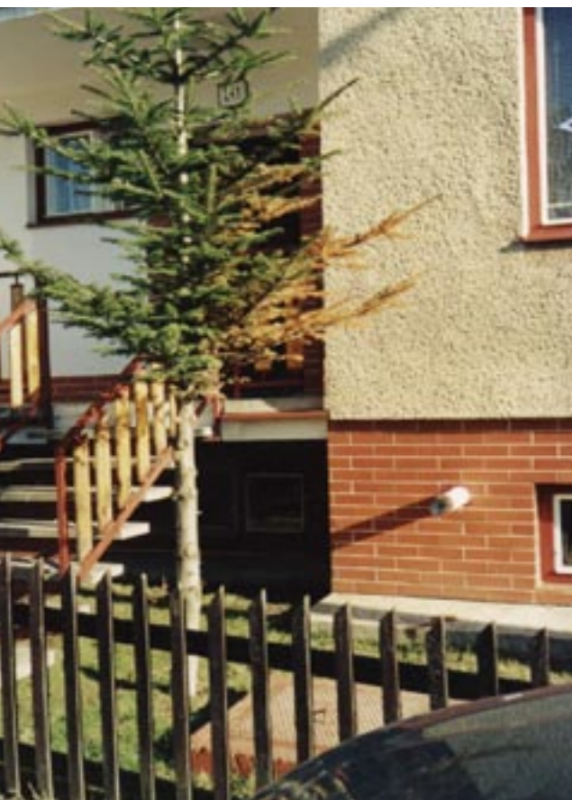
Uschnięte drzewo w wyniku wyrzutu spalin przez ścianę
