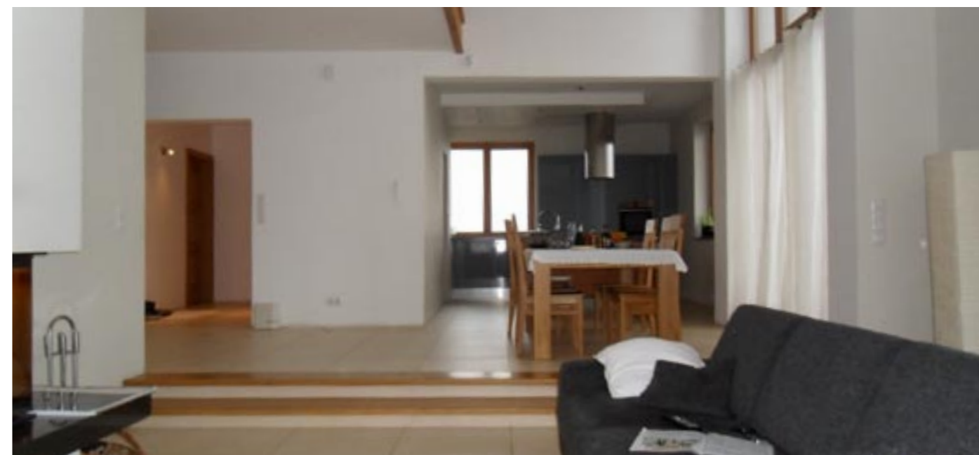
W większości pomieszczeń na podłozie z ogrzewaniem podłogowym jako wykładzina zastosowane są płytki ceramiczne
