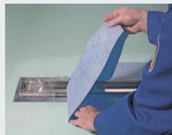
5 Naklejanie kołnierza uszczelniającego
