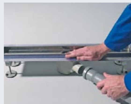
3 Podłączanie do kanalizacji
