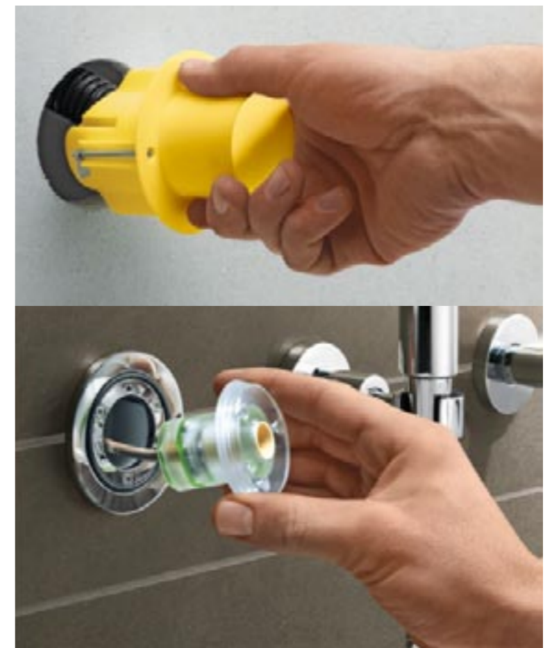
Ukryte gniazdko zestawu osadza się w ścianie tak, jak kontakt elektryczny. Do podłączenia z mikserem służy kabel umieszczony w pustej rurce
