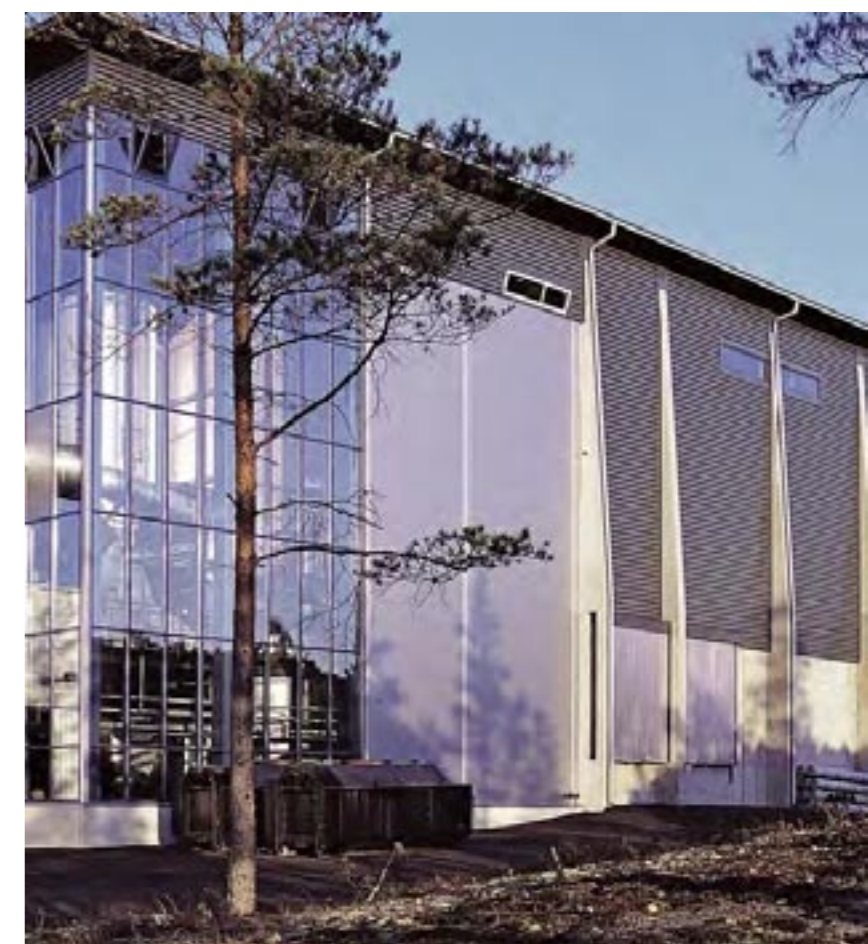
Elektrociepłownia na biomasę wybudowana przez Wärtsilä Biopower
