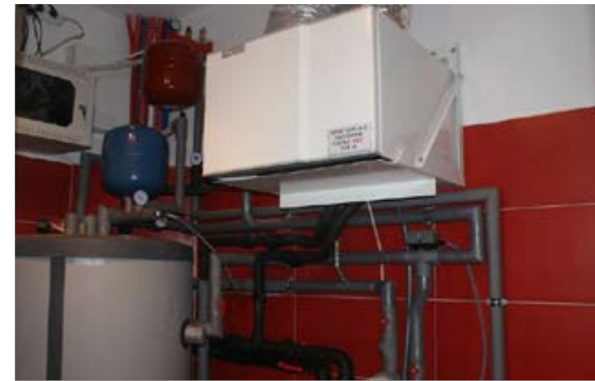
3 Moduł wentylacyjny NIBE FLM zapewniający wentylację wywiewną z odzyskiem ciepła przy współpracy z pompą ciepłą NIBE F1150 zainstalowaną w domu jednorodzinnym w miejscowości Zimin pod Poznaniem
